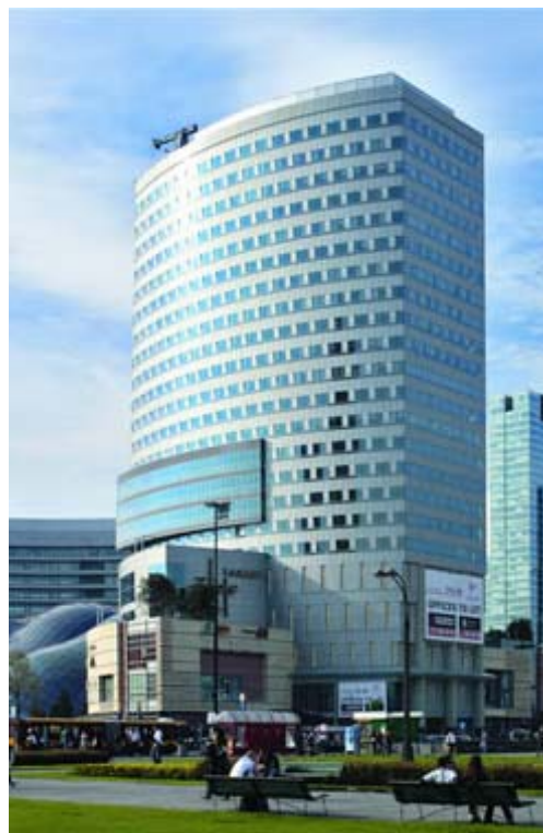
Skylight Złote Tarasy 22 000 m 2
